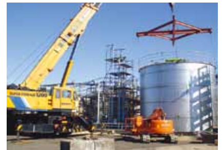
タンクの製作・据付
