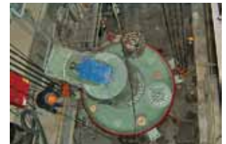
引き込み工法による据付
