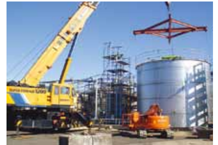
タンクの製作・据付
