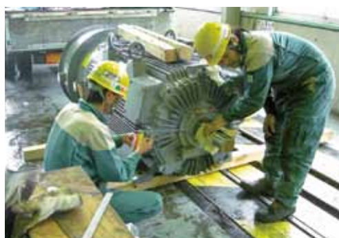
電動機のメンテナンス
