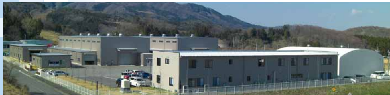
配管製作工場
