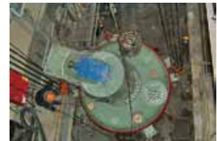
引き込み工法による据付
