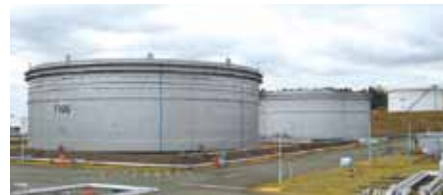
大型タンク開放検査
