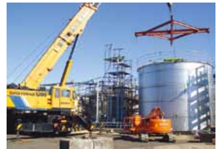
タンクの製作・据付
