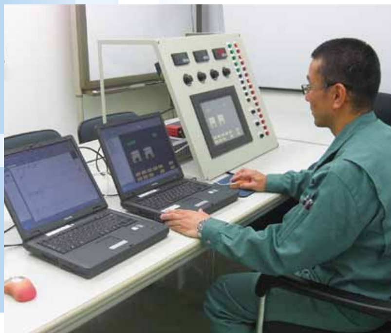
PLCタッチパネルシステムの構築
